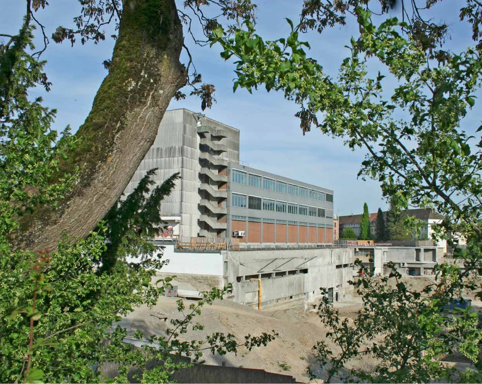
Gewerbegebäude Güterstrasse 8, nach Rückbau der Kehrichtverbrennungsanlage, 2015
